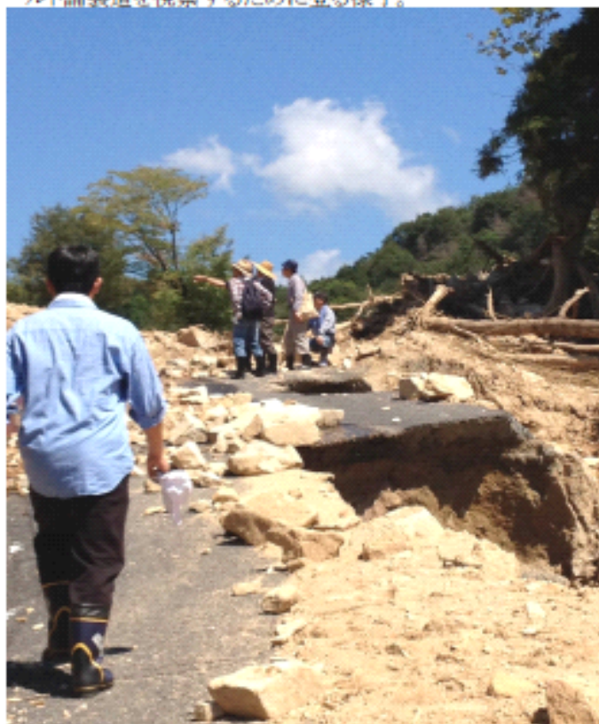
④ゴルフ場だった場所へ山頂から流れ込んできた土石類が、アスファルト舗装道を覆っている。道路だったところに堆積した土石類や山から流れてくる水からは、暴泉がしていた。
